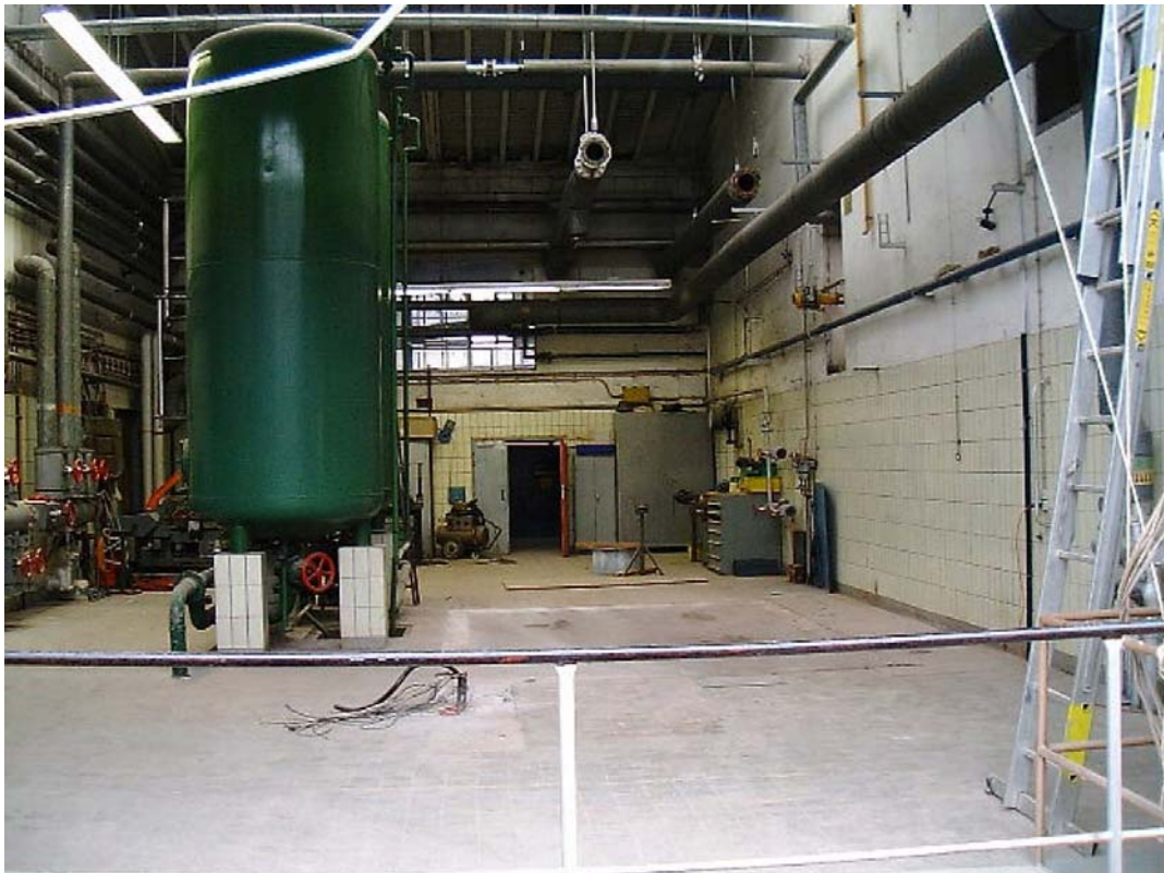
Das entkernte alte Heizwerkgebäude
